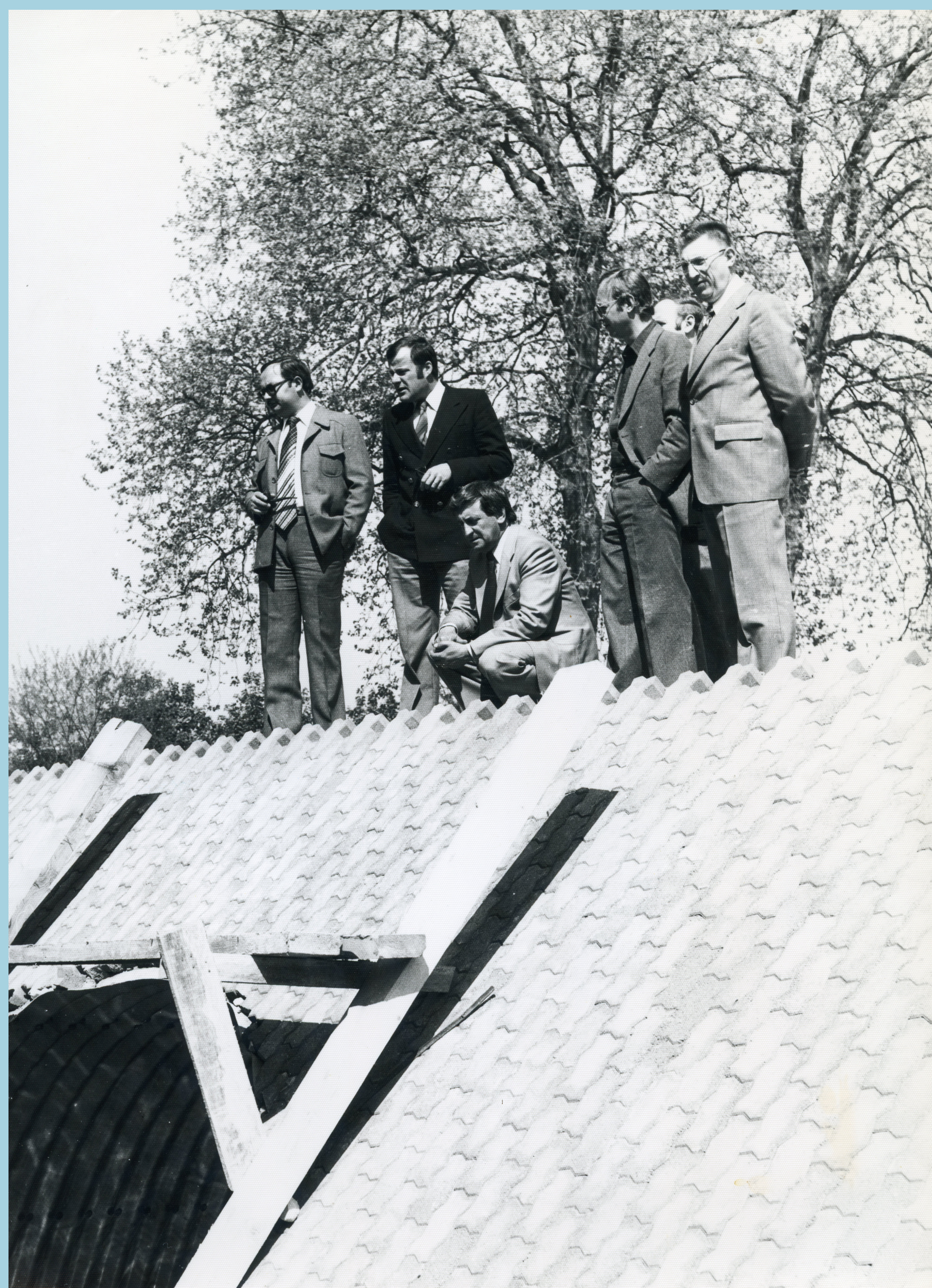
AMCB - 29W20 - Travaux pour le boulevard de l'Industrie (1987)
